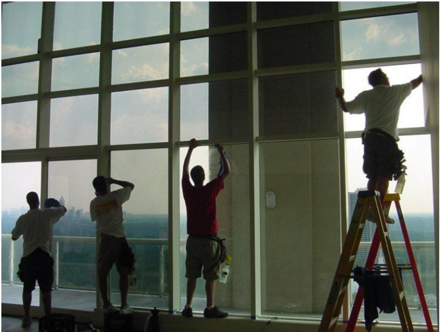
*Las láminas de control solar reducen la factura energética.*
